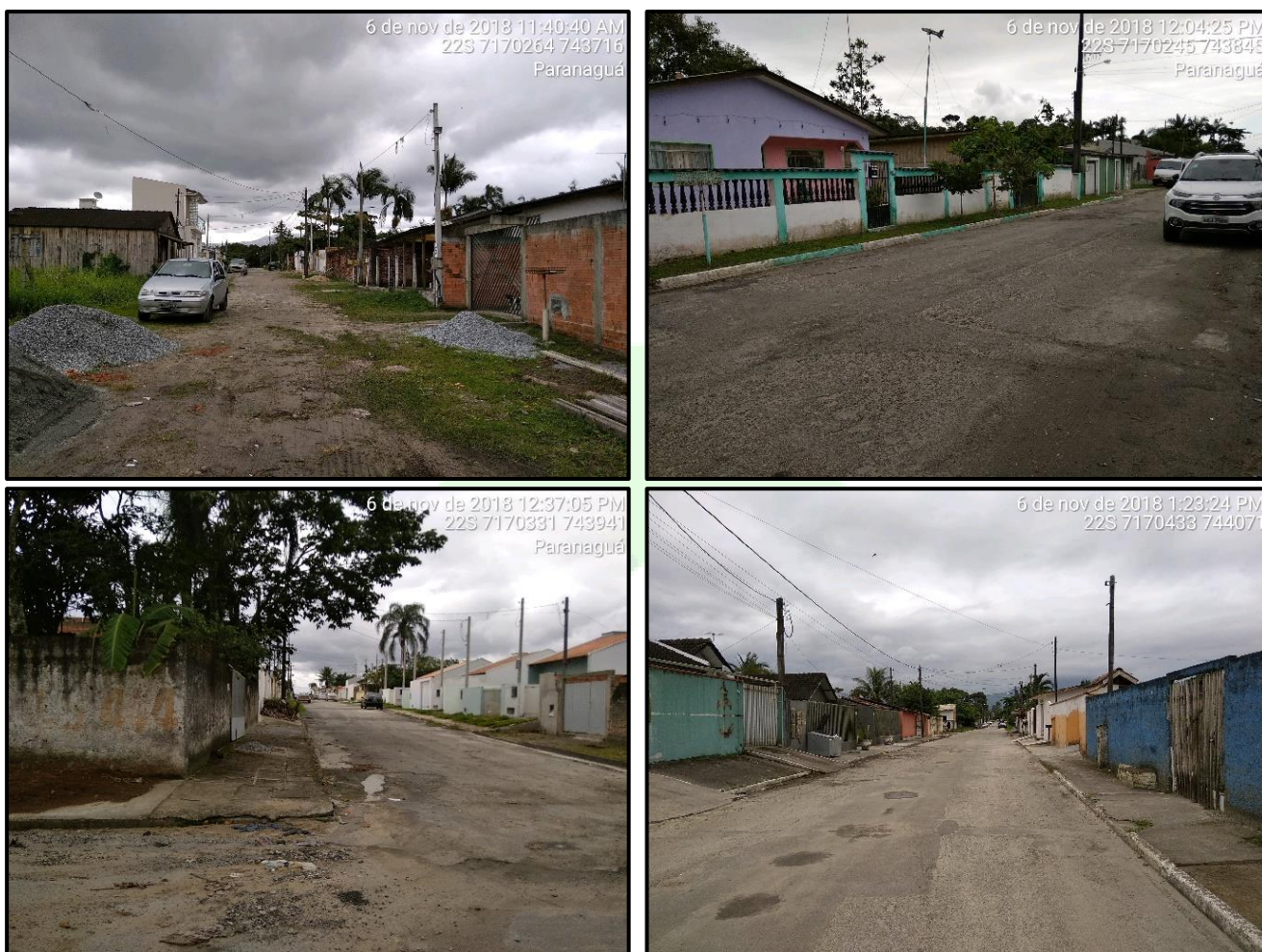
Figura 69. Pavimentação das ruas na zona ocupada da área Emboguaçu.
